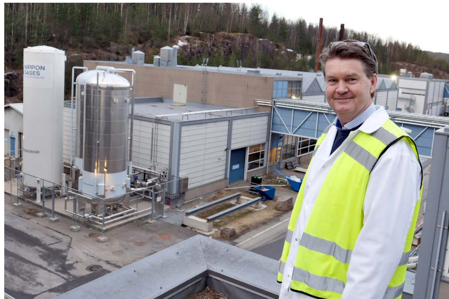
Erlend Aadland viser stolt frem Ringnes' nye CO 2 -anlegg på Gjelleråsen.
